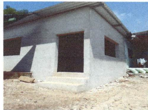
Foto 2 finalizada el aula con su muro perimetral de block y soporte de estructura metálica y sustituida su lámina con lámina de aluzinc.
