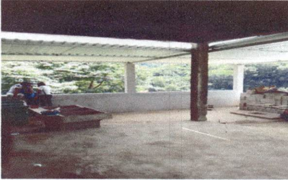
Foto 1. Cocina finalizada con su muro de contención, muro perimetral y sustituida su estructura con metal y lámina de aluzinc.
