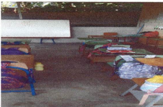
Foto 3. Aula finalizada con su muro perimetral de block, piso nuevo de torta de concreto y techo de soporte de estructura metálica con lámina nueva de aluzinc.
